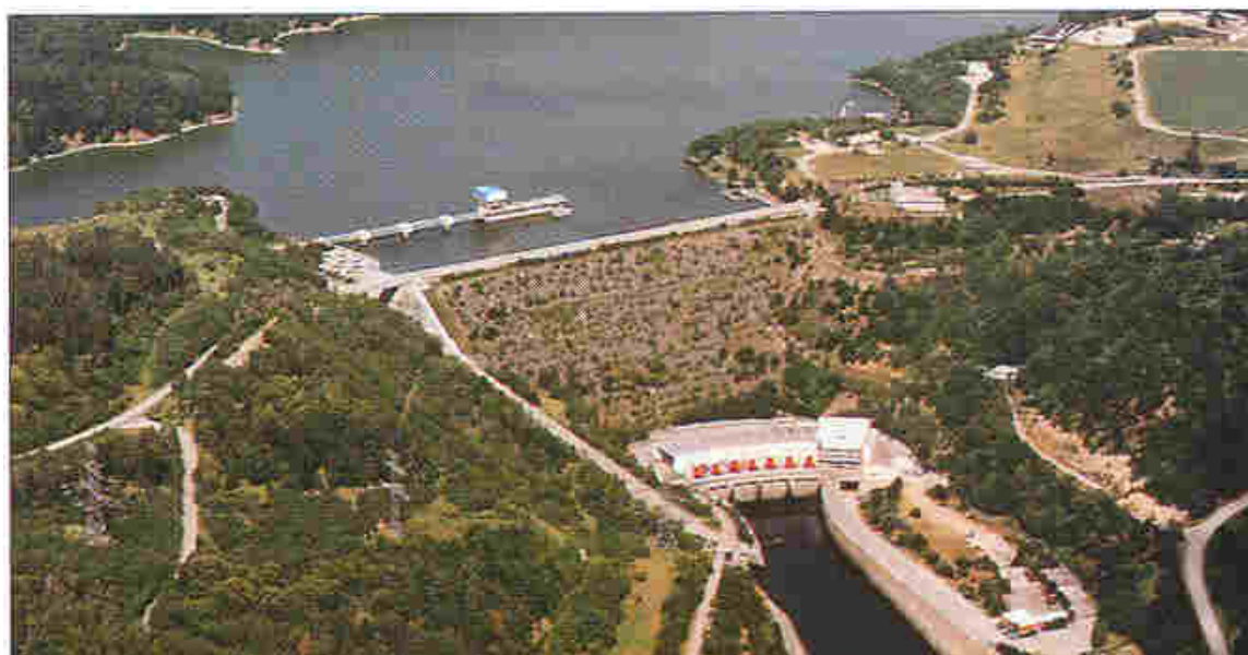
Obr. 1 Pohled na sypanou hráz a elektrárnu (zdroj)
